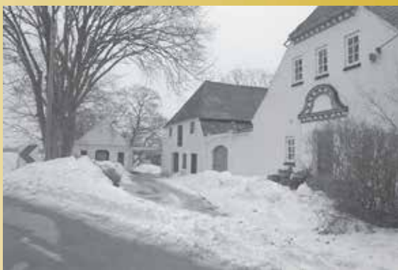
Bedre Byggeskik / Nybarok
