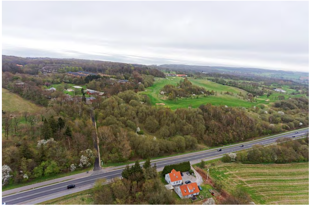
Figur 8-18 Drone nord, eksisterende forhold
