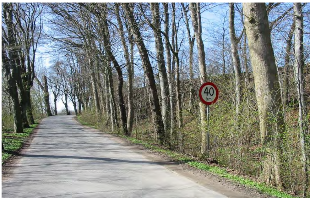
Figur 7-13 Afgravning af terræn mellem knækket af alléen og den gamle nord-sydgående landevej.
