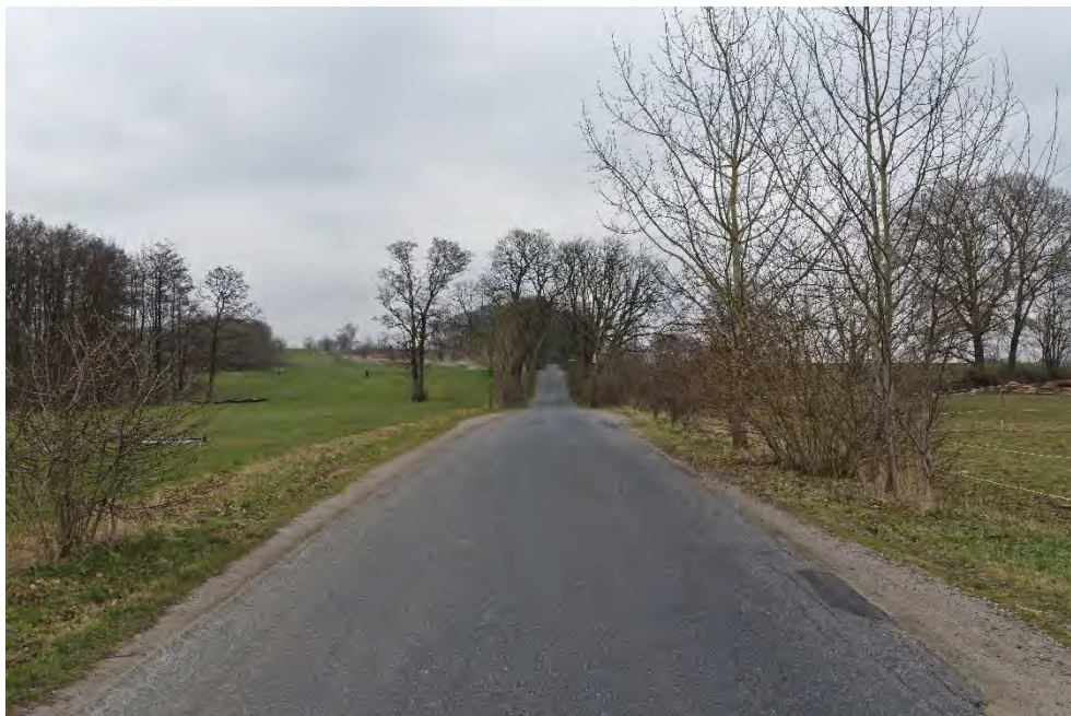
Figur 8-14 Fotostandpunkt 03, eksisterende forhold.
