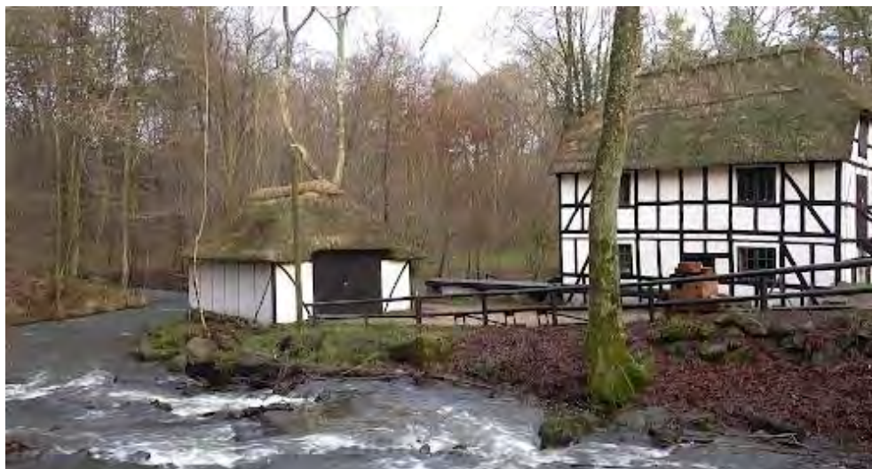
Figur 7-7 Skovmøllen ligger hvor åen kunne opstemmes og skabe fald, så møllens hjul kunne drives.
