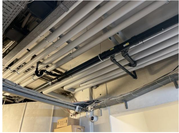
#30 Kælderetagen. Alle rør er skiftet i kælder i forbindelse med rørudskiftning i projekt 6 og 24.
