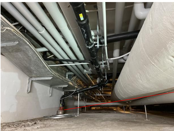
#5 Projekt 52 Udskiftning af afløbsrør til køkken.
