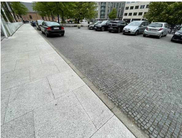
#11 Projekt 64. Forplads: Tagpappmembran under belægning er renoveret.
