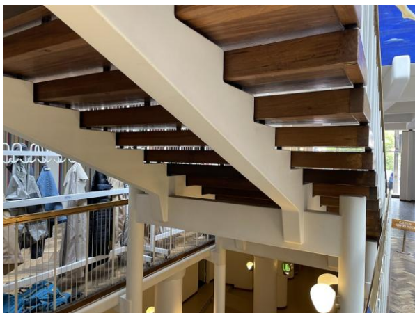
#22 Projekt 82 Underside af trappe.
