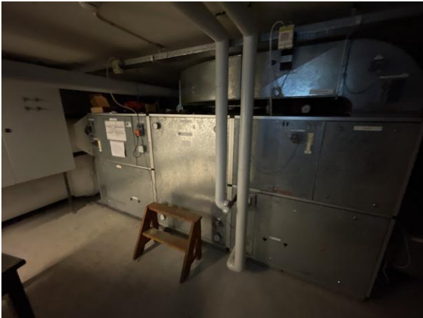
#1 Projekt 13 Udskiftning af motor på ventilationsanlæg fra 1990.
