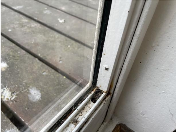
#13 Projekt 58 Vinduesparti i rådhusen er renoveret.
