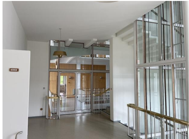
#4 Projekt 45 Renovering af puds, indvendigt i tårn.
