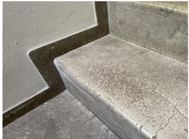
#26 Magnesitbelægning på trappe.
