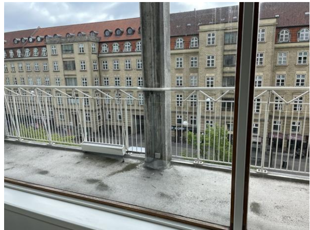
#16 Projekt 72 Katodisk renovering af beton udvendigt ved og på rådhusårnet.
