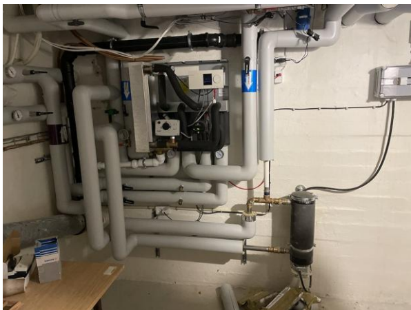
#19 Projekt 79 Opkogs-system monteret på nyt røranlæg efter stor asbest sanering men før rengøring af kabelbakker (udført ved projekt 6).
