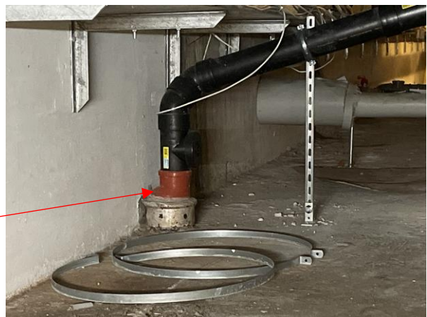
#6 Projekt 52 Afløbsinstallationer er skiftet indtil afløbsrør af jer i kældrer.
