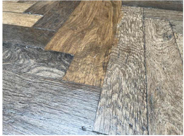
#24 Projekt 84. Udskiftning af træstave ved fræsning i de øverste mm trægulv.
