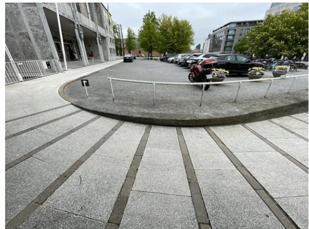
#12 Projekt 64. Forplads: Tagpappmembran under belægning er renoveret.
