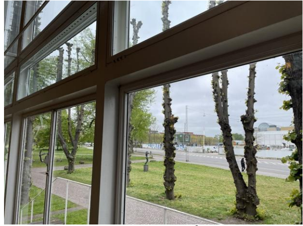
#14 Projekt 58 Vinduesparti i rådhusen er renoveret.
