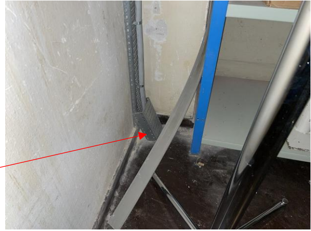
#8 Projekt 57, Etablering af 63 amp stik i hallen. Kælderrum: Der er boret i loft til rådhus hallen og gennem gulv til krybekælder.
