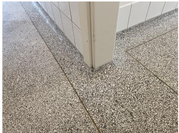
#28 Projekt 7 og 51 Renovering af toiletter. Oversigtsbillede af renoverede toiletter på 3 og 4 sal ved tårnet.
