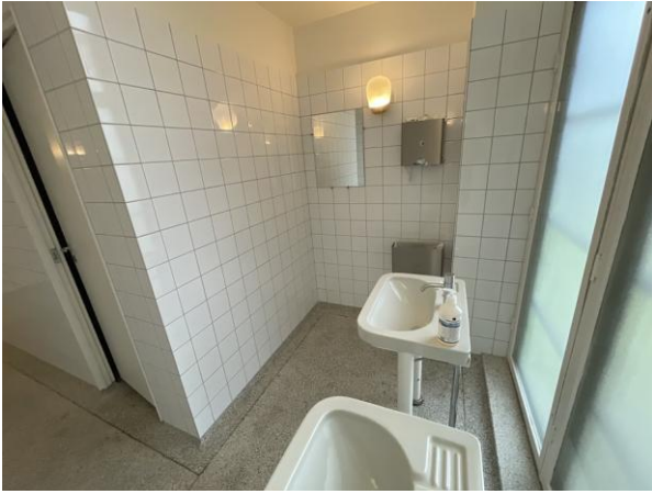
#29 Projekt 7 og 51 Renovering af toiletter. Oversigtsbillede af renoverede toiletter på 3 og 4 sal ved tårnet.
