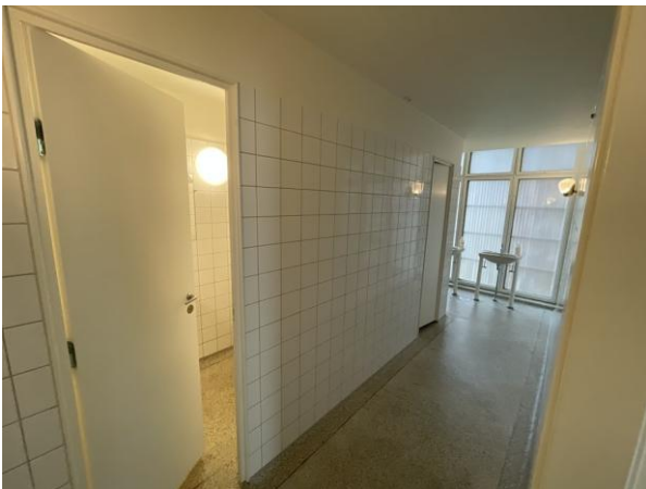
#27 Projekt 7 og 51 Renovering af toiletter. Oversigtsbillede af renoverede toiletter på 3 og 4 sal ved tårnet.
