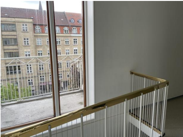
#3 Projekt 45 Renovering af puds, indvendigt i tårn.
