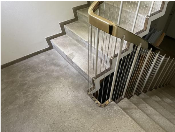
#25 Magnesitbelægning på trappe.
