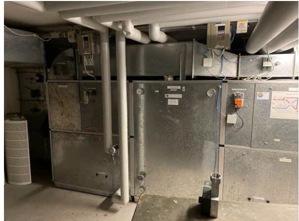
#2 Projekt 13 Udskiftning af motor på ventilationsanlæg fra 1990.
