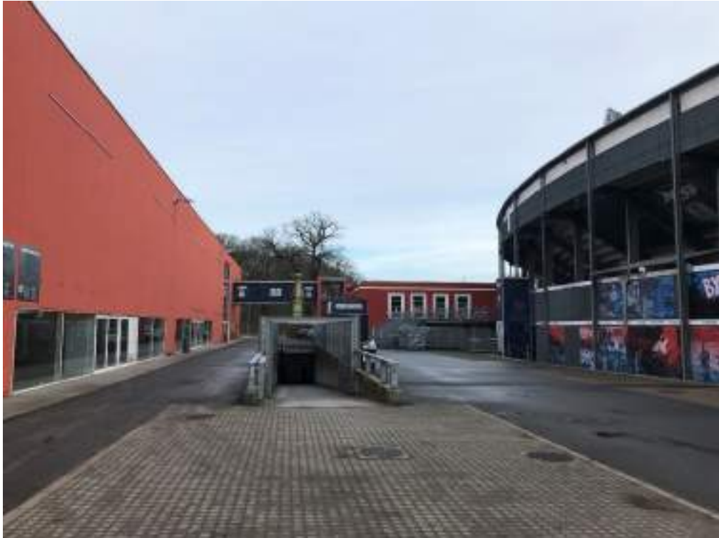
Figur 7-7. Mellemrummet mellem Arena og stadiontribunen. herunder flere småanlæg. Arealet på den vestlige side af stadionanlægget opleves som et lukket gårdrum, der kantes af bebyggelser, skråningsanlæg og en snæver åbning fra stadionområdets ankomstarealer i nord. Området har karakter af bagside, og med Sportens Hus, som afgrænser rummet mod nord, begrænses den visuelle forbindelse til ankomstarealerne.
